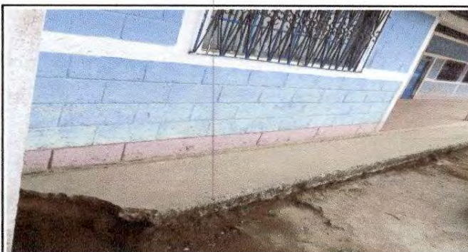
Foto 6: Reparación de banquetas de concreto
