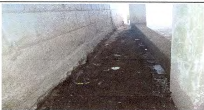
Foto 5: Reparación de cuneta de concreto
