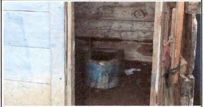
Foto 8: Sustitución inodoro + Sustitución de accesorios de inodoro (contra llave, tubo de abasto)
