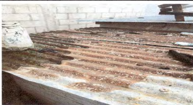
Foto 1: Sustrucción de lámina, por lámina troquelada alucin calibre 26 + Sustrucción de elementos de fijación
