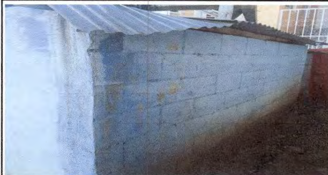
Foto 14: Repello + Cernido en muro
