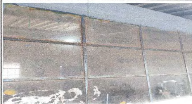
Foto 4: Sustrucción de vidrios
