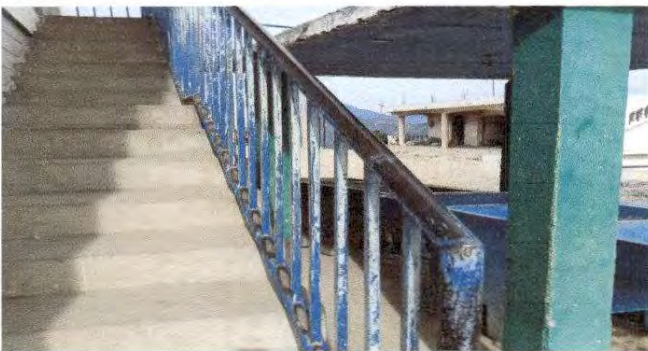
Foto 9: Mantenimiento de barandas de metal
